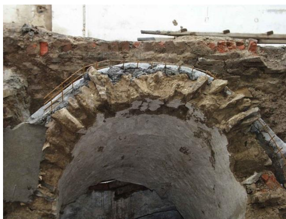
Obrázek 6.: Původní vstup do středověkých sklepů, které byly po rozsáhlé opravě zachovány [2].
