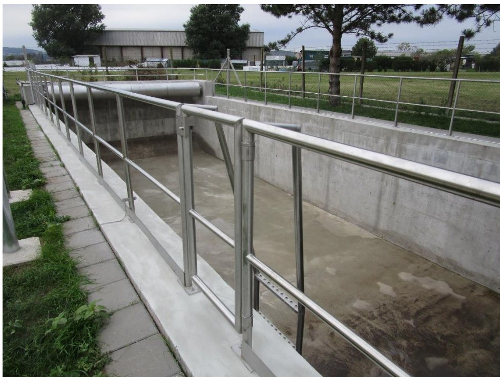
Obrázek 8.: Dešťová zdrž po sanaci
