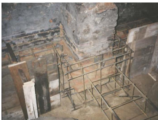
Obrázek 9.: Rozšíření základů v 1.PP. při nástavbě domu.
