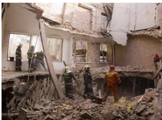
Obrázek 3.: Zřícená střední zeď, sesuté stropní klenby (internet).
