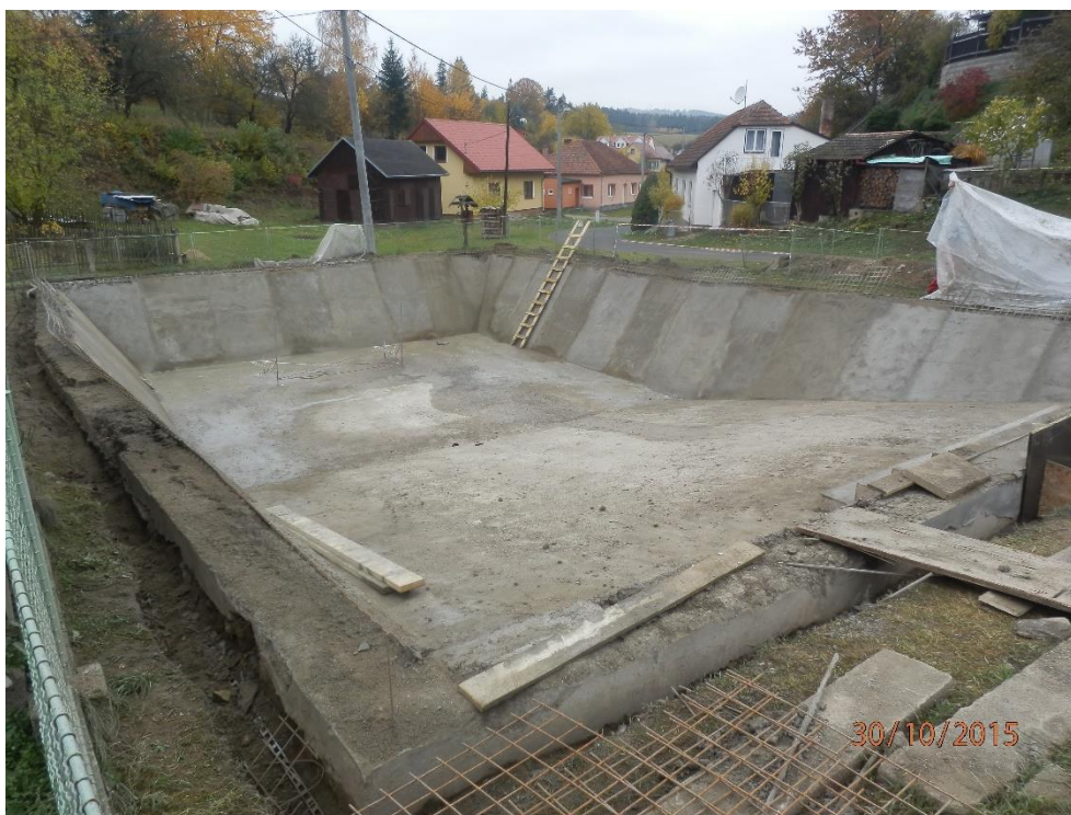
Obrázek 6.: Stav po dokončení stěn
