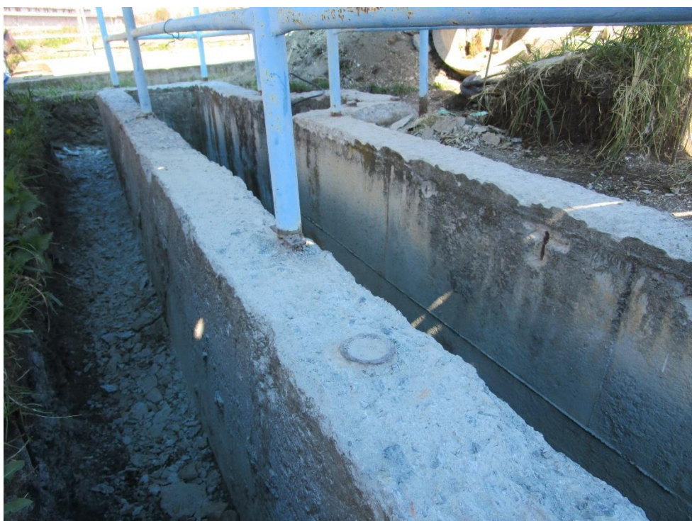
Obrázek 2.: Mechanické čištění konstrukce
