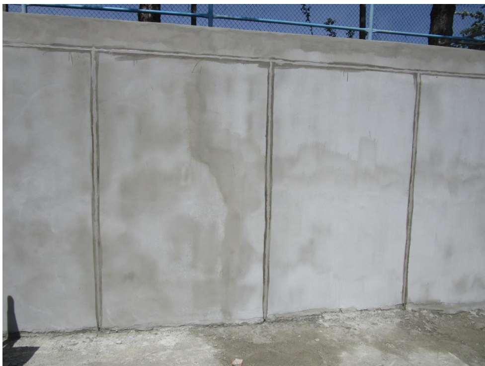
Obrázek 5.: Těsnění pracovních spár dešťové zdiře
