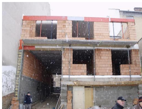
Obrázek 14.: Celkový pohled na novou výstavbu po odstranění původního zdiva
