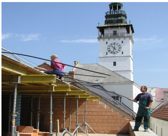
Obrázek 13.: Příprava na předpínání konzoly stropu nad 3.NP.
