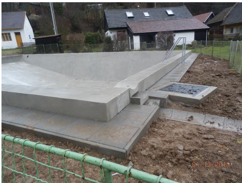
Obrázek 10.: Nádrž po opravě
