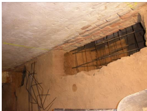
Obrázek 13.: Detail jednoho úseku během provádění 1. fáze pod vnitřní nosnou stěnou
