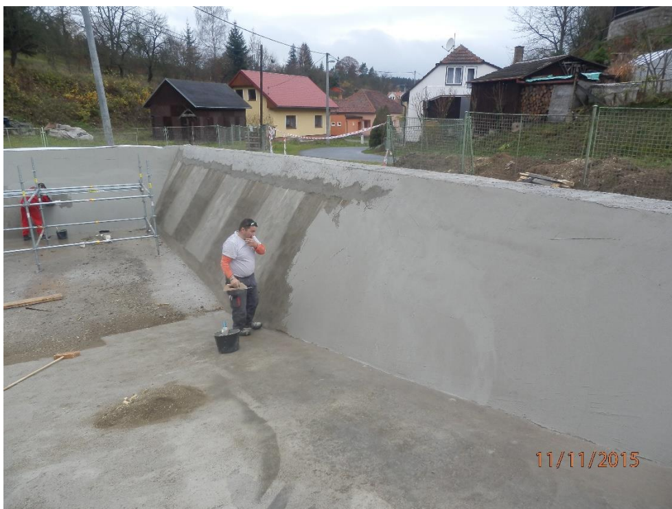
Obrázek 8.: Aplikace hydroizolační stěrky
