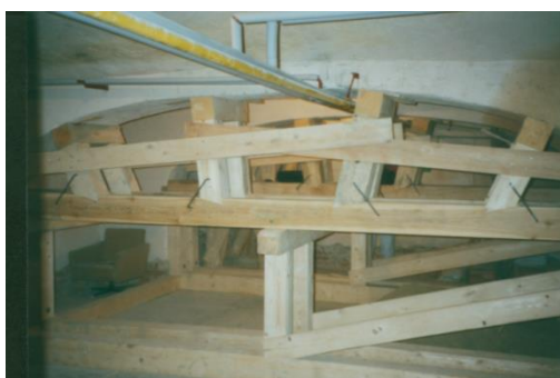
Obrázek 7.: Podepření klenbového pásu v objektu z roku 1905.
