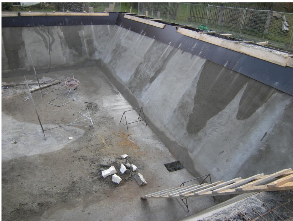
Obrázek 7.: Betonáž hlavy
