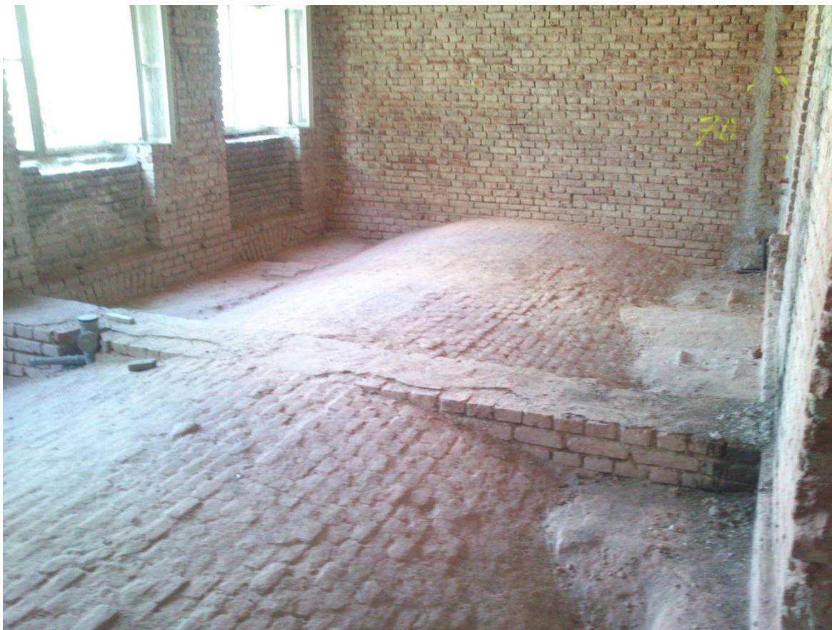
Obrázek 1.: Typická ukázka klenbového stropu z 18. století připraveného pro následné roznášecí podlahové konstrukce
