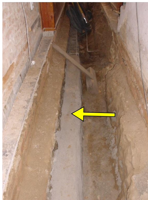
Obrázek 5.: Celkový pohled na rozšířený základ v chodbovém traktu. Šipka ukazuje na novou ŽB část základů.
