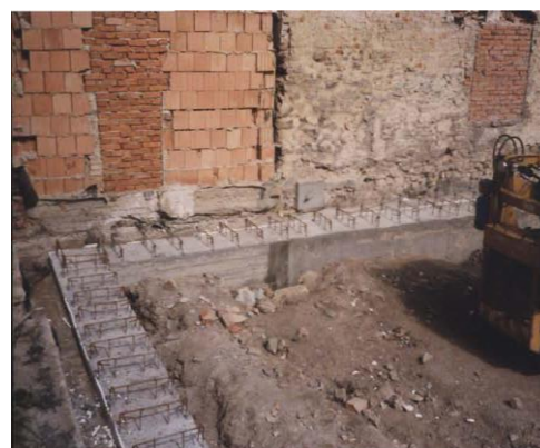
Obrázek 17.: Nový základ po vybetonování - viz Obr. 14 až 16.
