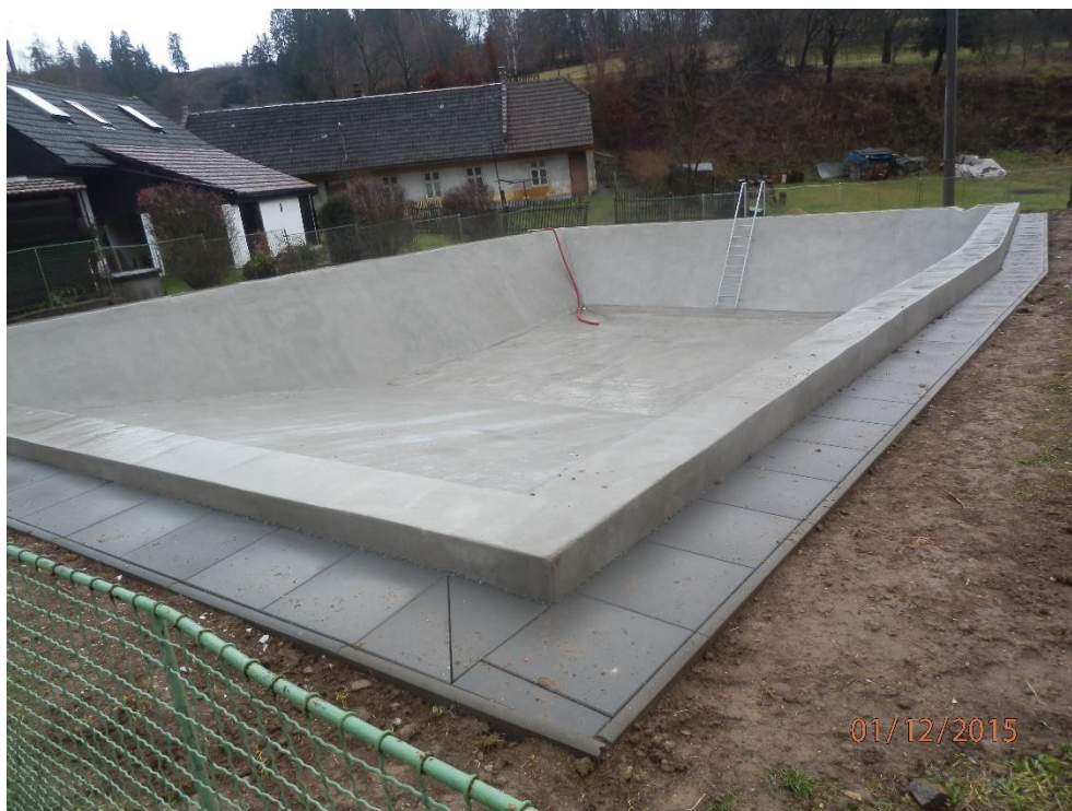
Obrázek 9.: Nádrž po opravě
