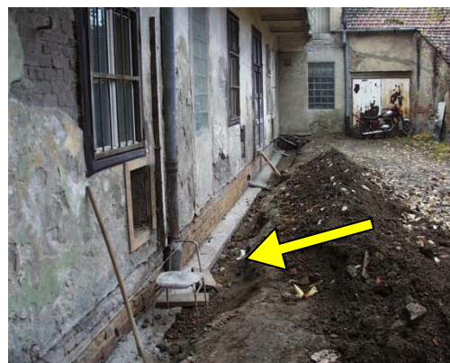
Obrázek 10.: Přibetonování základů zvenčí domu (šipka).
