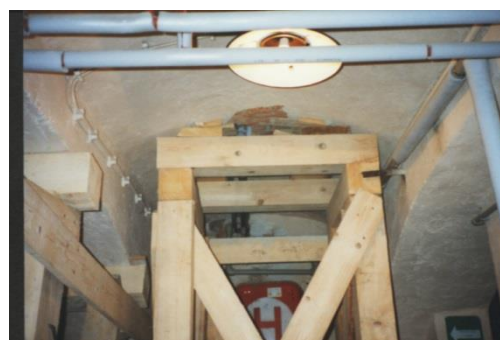
Obrázek 8.: Podepření klenby mezi klenbovými pásy – viz Obr. 7.
