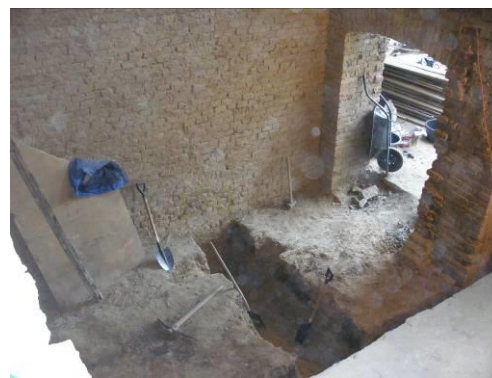
Obrázek 12.: Provádění výkopových prací v interiéru pro dadatečně zřizované základové pasy
