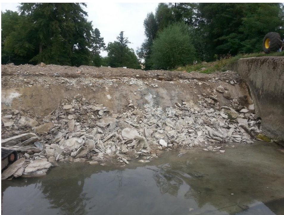
Obrázek 4.: Bourání degradované původní konstrukce
