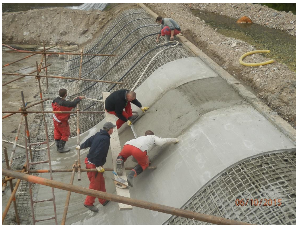
Obrázek 6.: Aplikace sanačního materiálu
