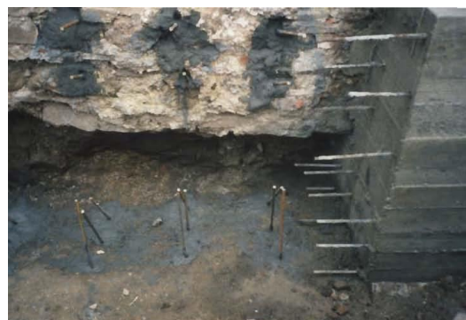
Obrázek 15.: Betonáž rozšíření základu po částech – viz Obr. 11, 14, 16, 17.
