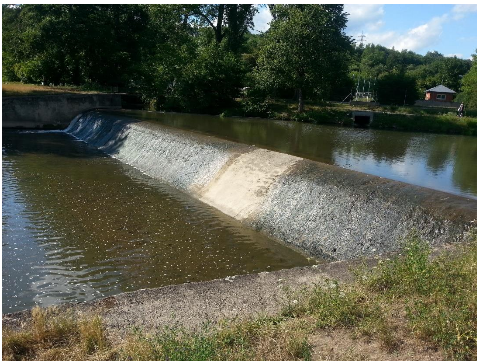
Obrázek 3.: Stav jezu před opravou
