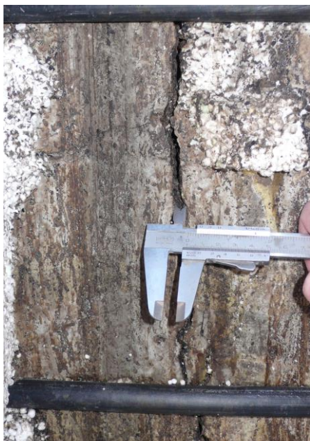
Obr. 2 a) Stena fermentora so širokou trhlinou b) hnedé až čierne výluhy digestátu (stena nádrže bola predopnutá až po vzniku trhlín).
