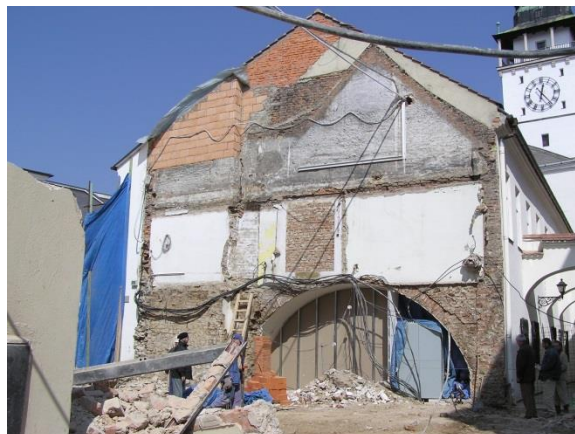
Obrázek 4.: Pohled na štít objektu po pravé straně po bouracích pracích.
