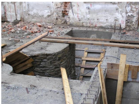
Obrázek 7.: Úprava vstupů do sklepů (v pozadí uliční fasáda) [2].
