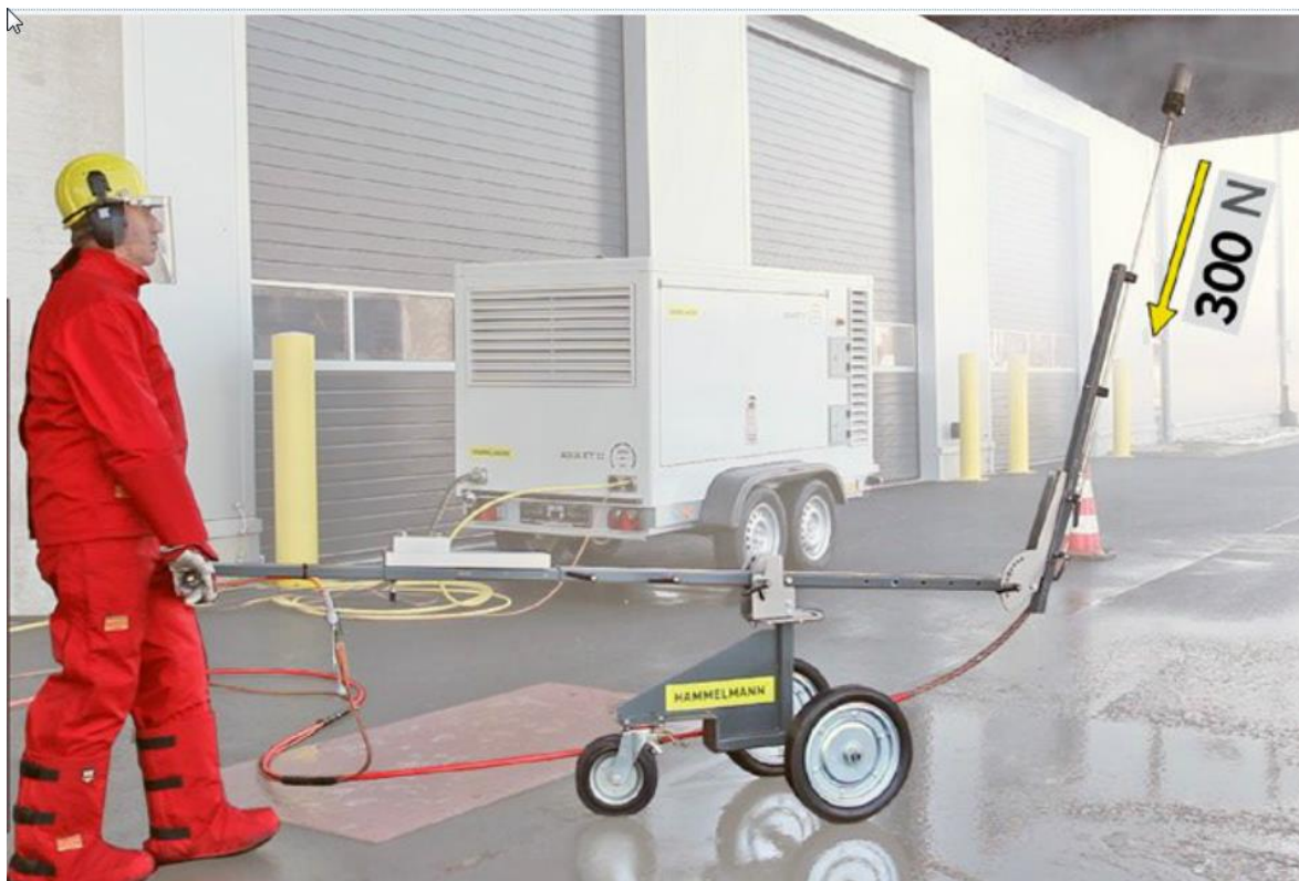
Obrázek č. 11 Použití JETBOJ – přípravku na sanaci povrchu betonového stropu.
