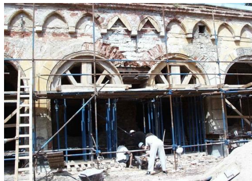
Obr. 19.: Průběh opravy – pilíř i základ odstraněny. Podepření a opravy kleneb.
