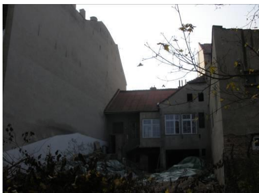
Obrázek 11.: Celkový pohled na původní objekt z dvorního traktu před zahájením prací
