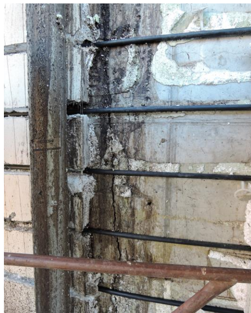
Obr. 2 a) Stena fermentora so širokou trhlinou b) hnedé až čierne výluhy digestátu (stena nádrže bola predopnutá až po vzniku trhlín).
