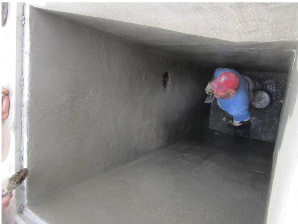
Obrázek 7.: Sanace šachet
