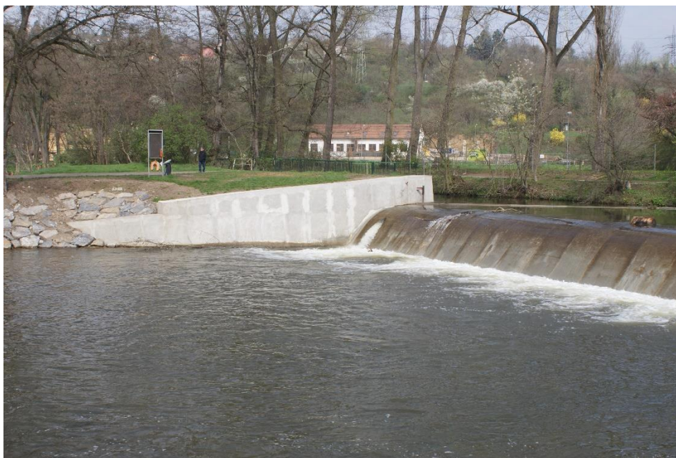
Obrázek 8.: Jez po sanaci
