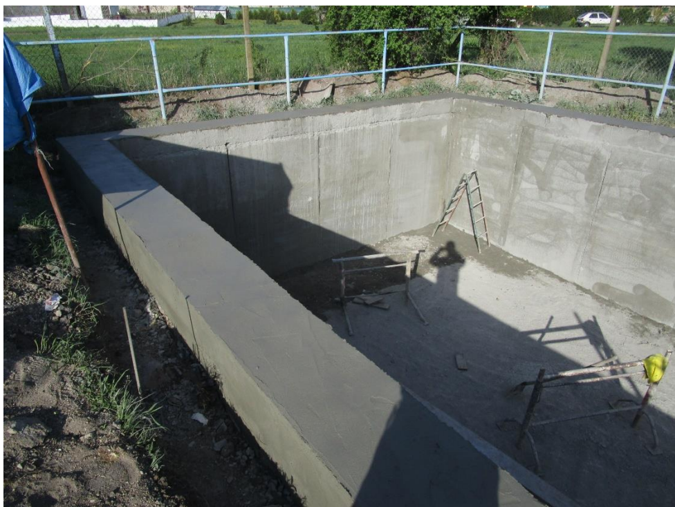
Obrázek 4.: Provádění sanace dešťové zdrže
