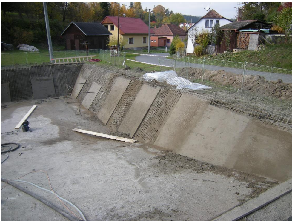
Obrázek 5.: Betonáž stěn stříkaným betonem
