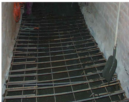
Obrázek 25.: Základová reverzní klenba v 1.PP. rekonstruovaného objektu (kulturní dům s knihovnou) z 19. století před započítím betonáže.
