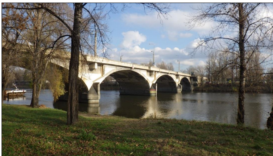
Obr.2: Návodní strana mostu na podzim 2015, pohled z holešovického břehu
