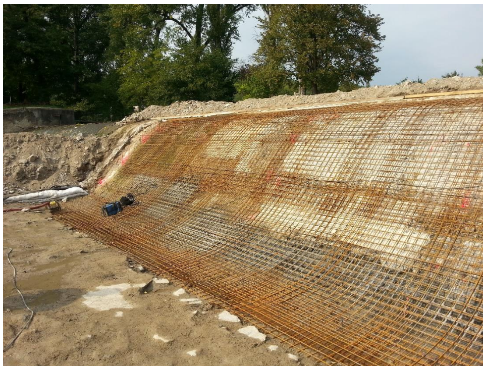
Obrázek 5.: Armování a kotvení
