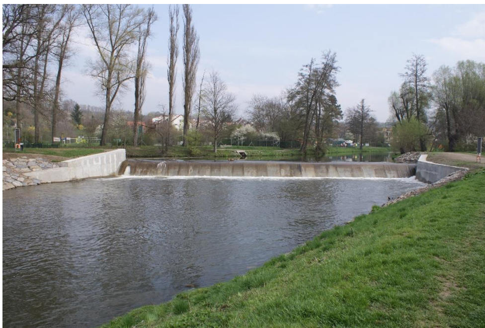
Obrázek 7.: Jez po sanaci
