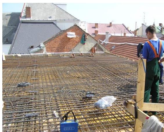
Obrázek 12.: Výztuž stropu nad 3.NP. nad uliční fasádou – předepnutá konzola vpravo - viz Obr. 13, 14.
