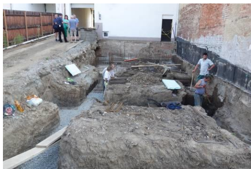
Obrázek 8.: Celkový pohled na staveniště v době provádění výkopových prací
