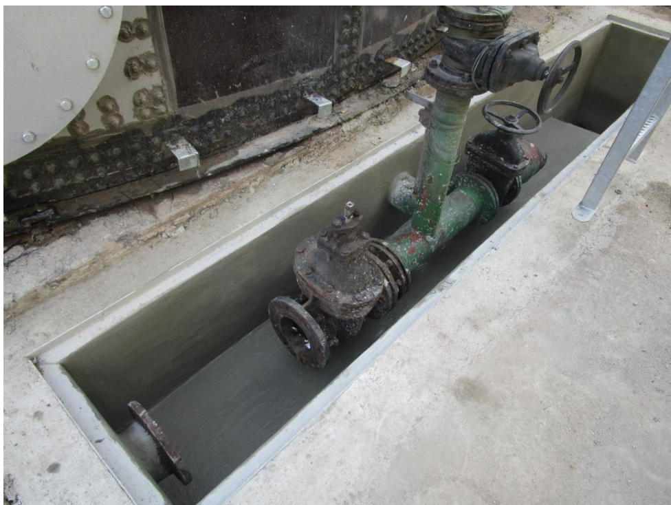
Obrázek 6.: Sanace technologických kanálů
