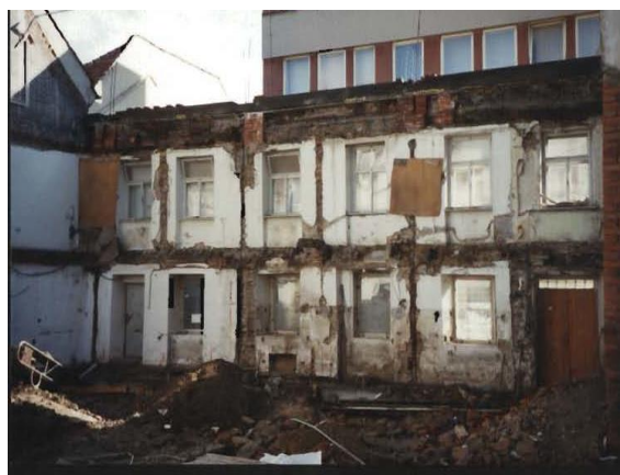
Obrázek 5.: Fasádní zeď po odbourání vnitřních částí domu. Tato zeď byla stabilizována svislým předpětím [1].
