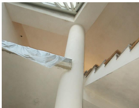
Obrázek 10.: Schodiště a centrální sloup po betonáži (viz Obr. 9).
