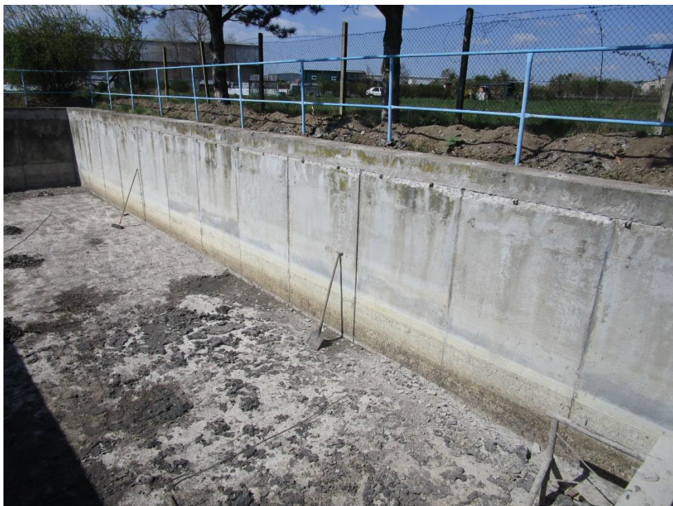
Obrázek 1.: Stav konstrukce před sanací
