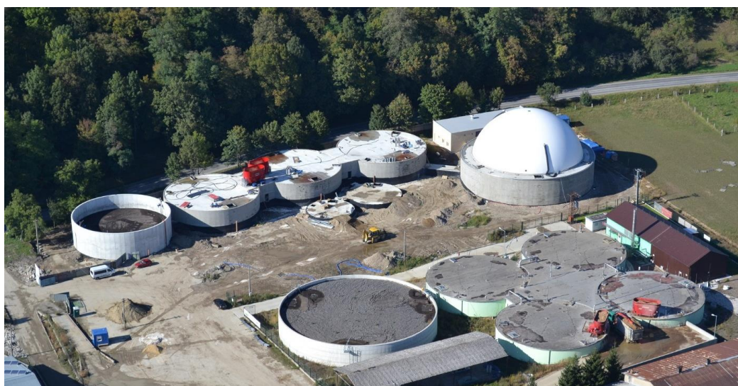
Obrázok 1.: Železobetónové valcové nádrže bioplynovej stanice
