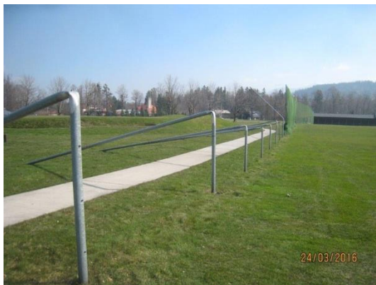
Obrázek 1.: Havarovaná konstrukce záchytné sítě.
