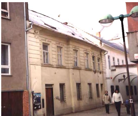
Obrázek 1.: Původní uliční fasáda, zčásti vyzděná z vepřovic (viz Obr. 18).
