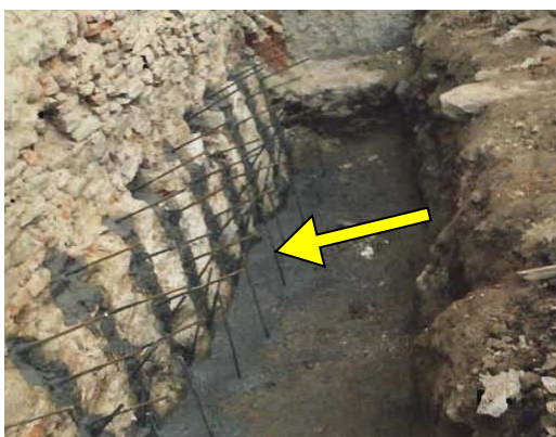
Obrázek 16.: Úprava starého základu mikrohřeby (šipka).
