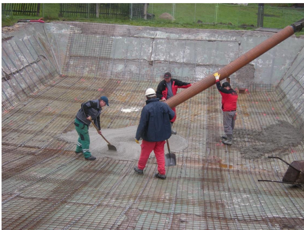
Obrázek 4.: Betonáž dna
