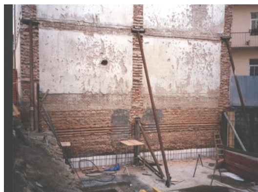
Obrázek 6.: Dodatečné zajištění štítové stěny vzpěrami při stavbě v proluce.
