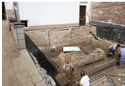
Obrázek 9.: Detail armokoše v místě navazujícího sousedního objektu.
