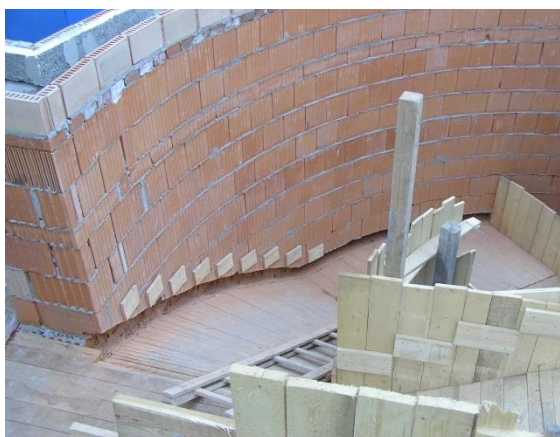
Obrázek 9.: Schodiště při stavbě (bednění, obvodová stěna, věnec).
