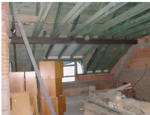
Obrázek 6.: Uložení středových vaznic na dostavované štítové stěny
