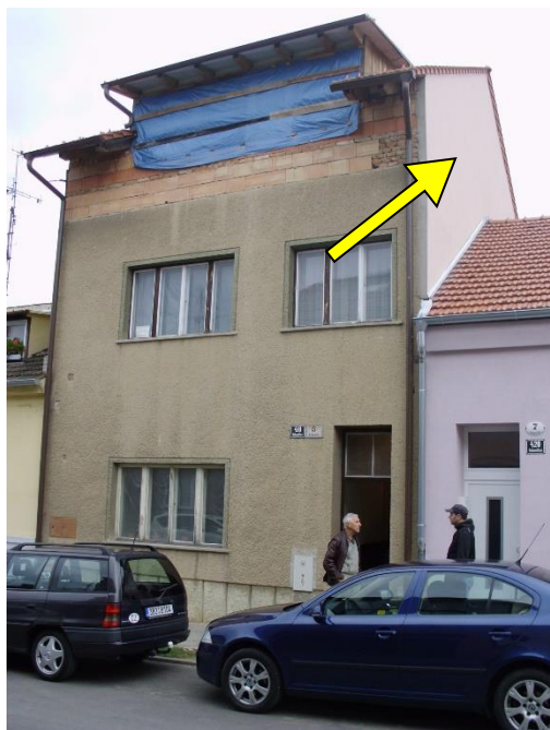
Obrázek 4.: Celkový pohled na rekonstruovaný objekt, vyznačena štítová stěna s nutností zesílení základů
