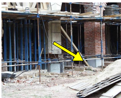
Obrázek 20.: Nový základ (šipka) a nově vyžděný zděný sloup zámku.
