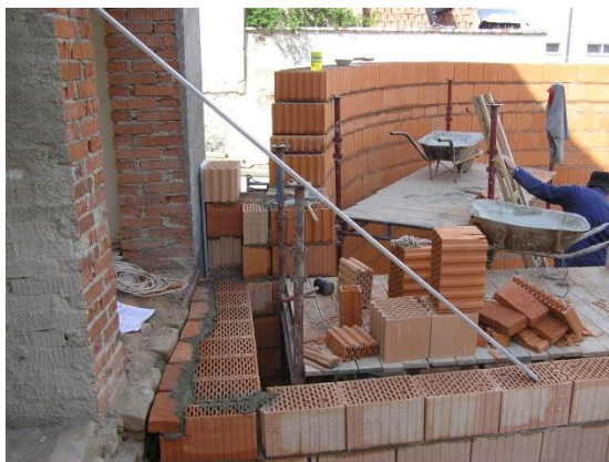
Obrázek 8.: Navázání nového zdiva na štít (viz Obr. 3).
