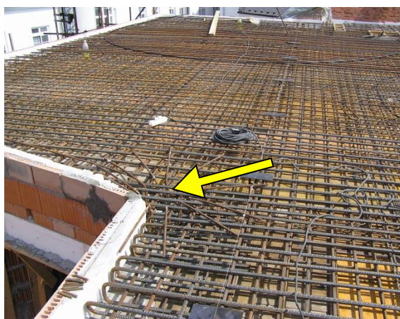
Obrázek 11.: Výztuž stropu nad 3.NP. u dvorní fasády. Osazená ocelová hlavice (šipka).
