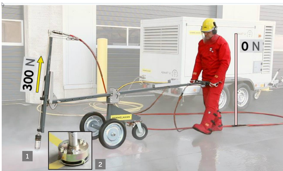
Obrázek č. 10 Použití JETBOJ – přípravku na sanaci povrchu betonové podlahy.
