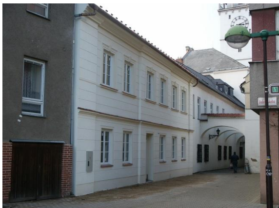
Obrázek 18.: Pohled na rekonstruovaný objekt z ulice. V pozadí radniční věž, stabilizovaná již dříve [4].
