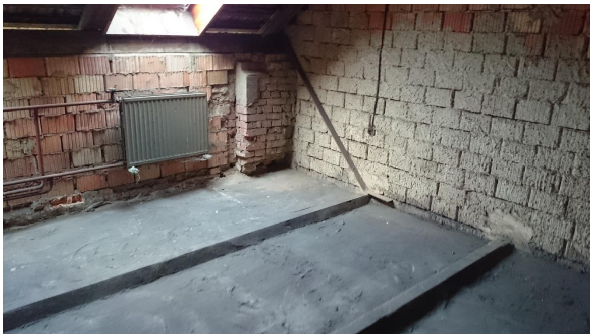
Obrázek 2.: Ukázka hurdiskové stropní konstrukce po odklizení předchozí vrstvy škvárobetonu
