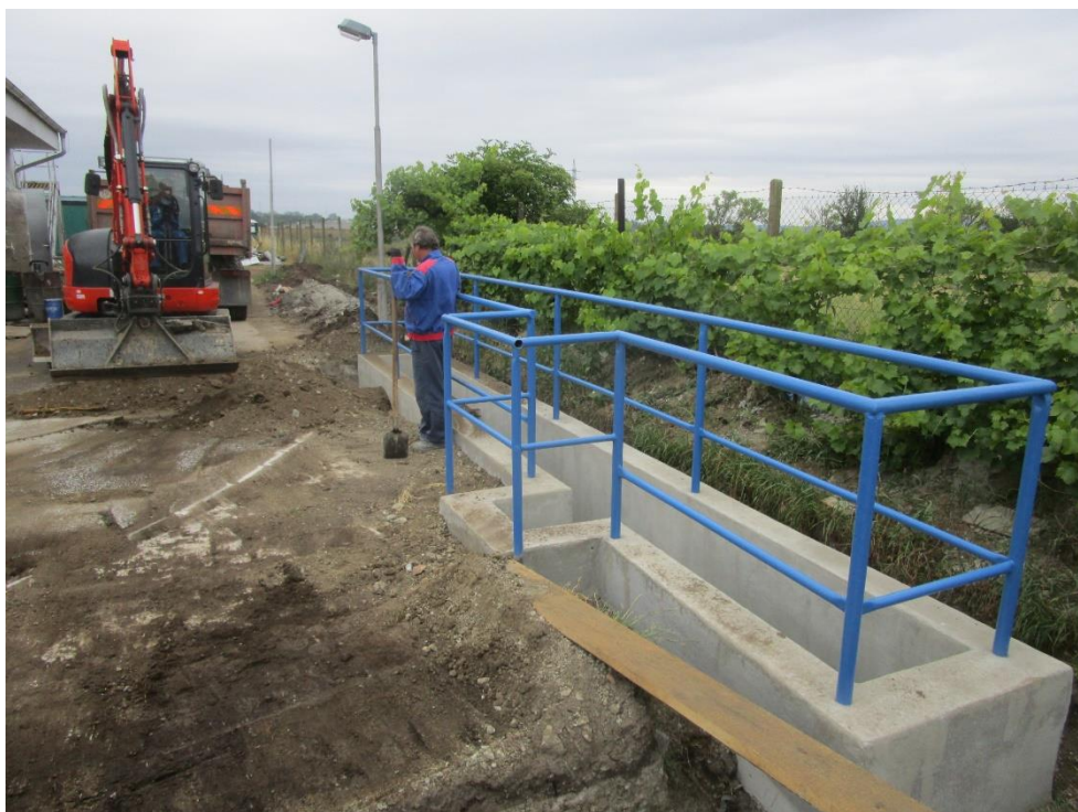
Obrázek 3.: Měrný objekt po sanaci
