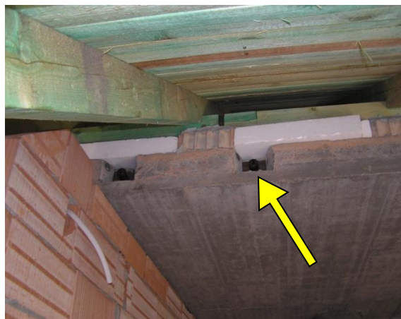
Obrázek 14.: Ukotvení předpínacích lan na okraji konzoly (šipka). Osazen krov.
