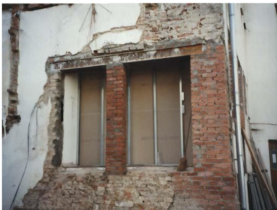
Obrázek 3.: Úprava dvojitého průchodu do přilehlého objektu u levého štítu.
