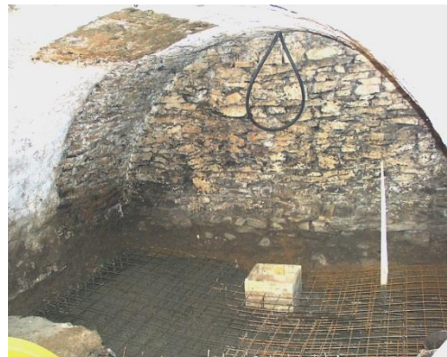
Obrázek 23.: Obrácená klenba ve středověkém sklepení – viz i Obr. 22, 25
