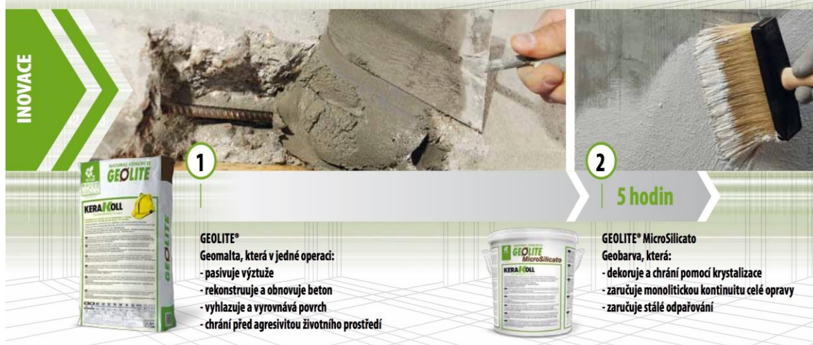
Obrázek č. 6 a 7 - Zjednodušení technologického postupu při splnění požadavků na sanaci dle normy ČSN EN1504
