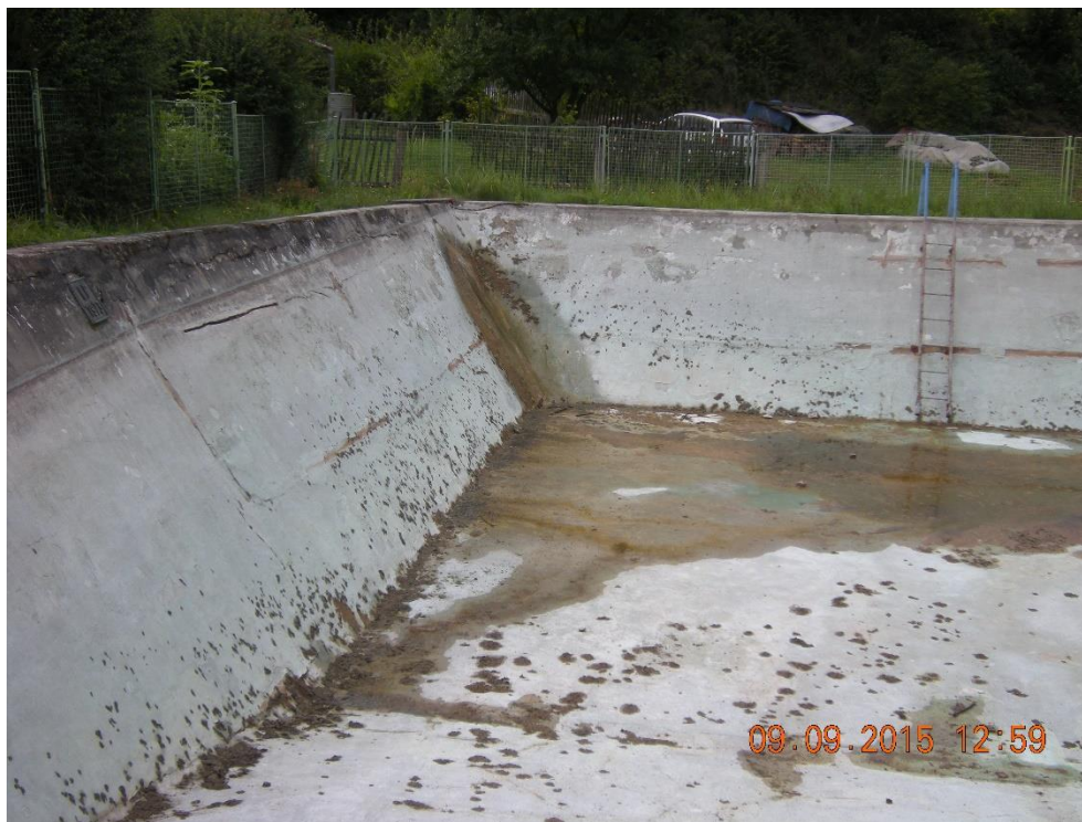
Obrázek 1.: Konstrukce před opravou
