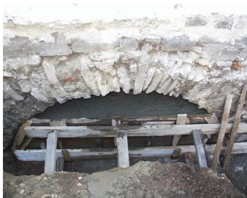
Obrázek 1.: Neočekávané středověké uspořádání kamenných klenbových základů pod uliční zdí městského domu.
